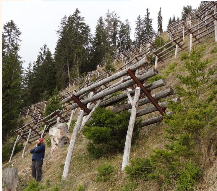
**Photos 33 et 34. Mesures de protection temporaires pour rétablir une protection de conifères contre les avalanches en région alpine dans une forêt endommagée par un incendie dans la municipalité de Trin (Suisse).**
