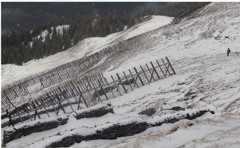
**Bild 29. Strukturelle Maßnahmen (Vordergrund) und Schutzwald (Hintergrund) gegen Lawinen.**
